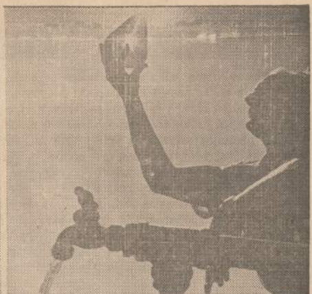
Už dešimt metų Amerikoje labai trūkti geriamo vandens, todėl daromi bandymai filtruoti naudotą vandenį. Prie Phoenix, Arizonoje pastatyti filtravimo įrenginiai, kurie kanalizacijos vandenį gryna smėlio ir augalų pagalba. Dešinėje chemikas apžiūri stiklo talpyklę su išvalytu vandeniu pavyzdį.
