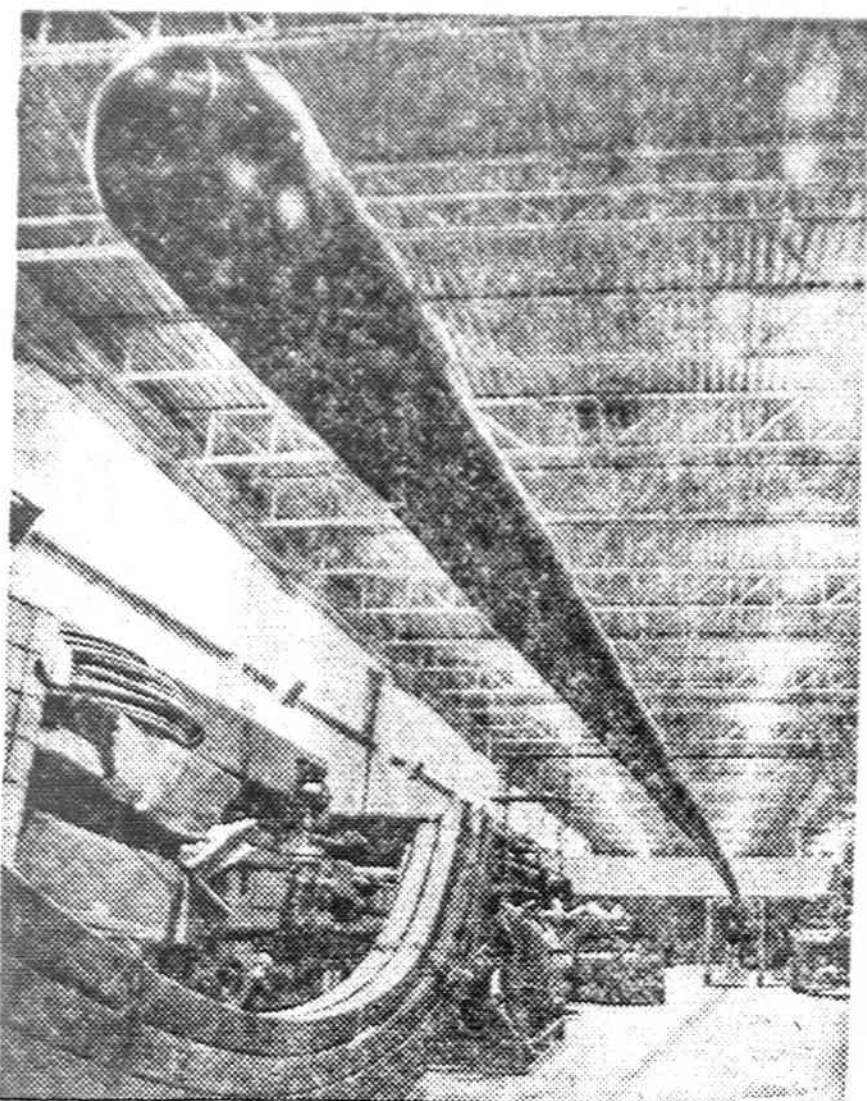
Tennessee Valley Authority elektros įėjinė savo katilams ir vamzdžiams valyti užsėk 36 milijonų dolerių ir suodžių siurblius - pūtiklius. Siurblys turi 56 pėdų ilgumo maišą.
