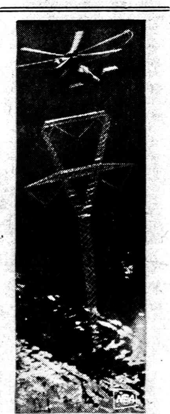
Helikopteris buvo labai naudingas tiesiant elektros laidų liniją Virginijos Dismal raistynose. Sunkių elektros stulpų nebuvo kaip atgauti. Helikopteris atgabeno 48 stulpus, kiekvienam stulpui sugaidamas tik 20 min.
