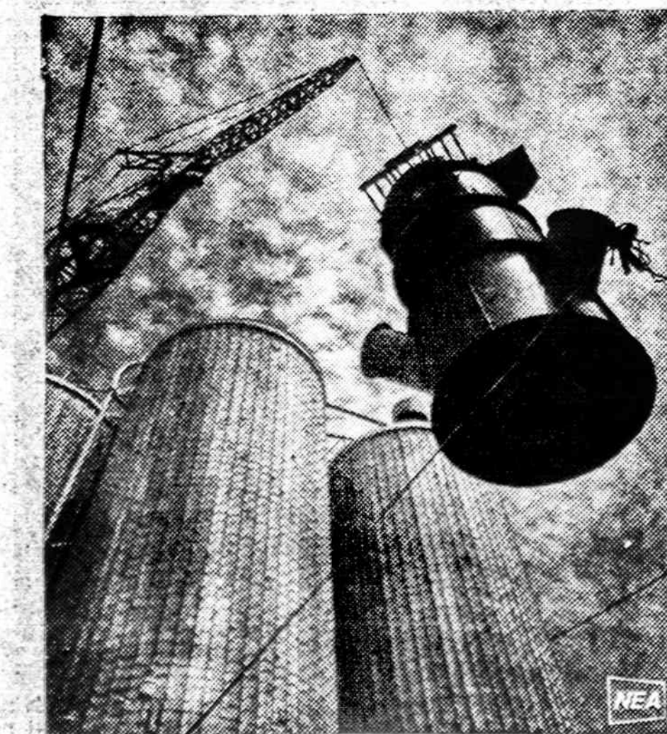
Susirūpinus oro teršimu vis daugiau imonių Amerikoje įtaiso savo kaminuose dulkes ir dūmus sutraukiančius filtrus. Paveiksle matomas didžiulis filtras keliamas Babco & Wilson įmonėje Georgijoje.
