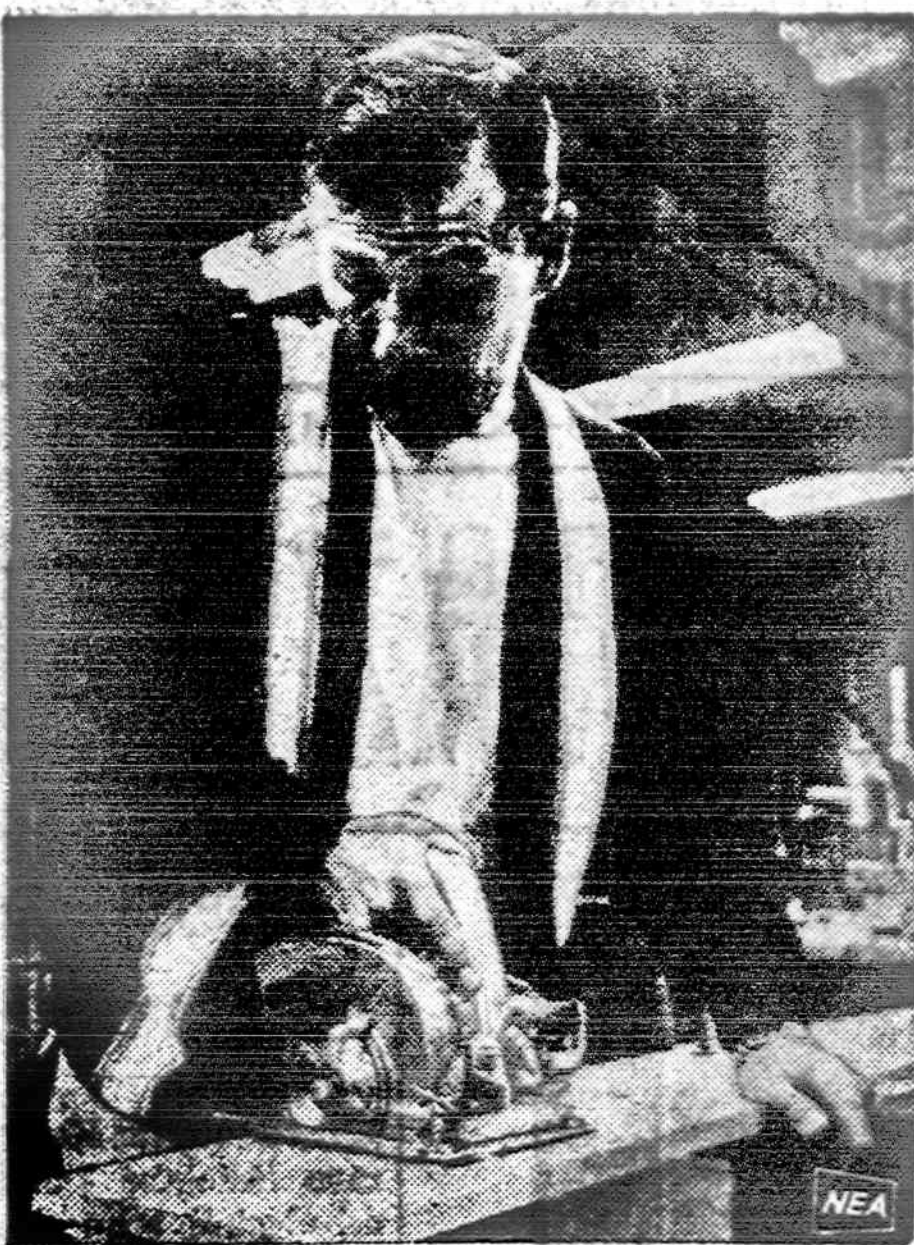
Imant į rankas elektros pūklą, reikia būtinai užsisagstyti, kad magnetinio galas nepatektų į pūklą dantis.
