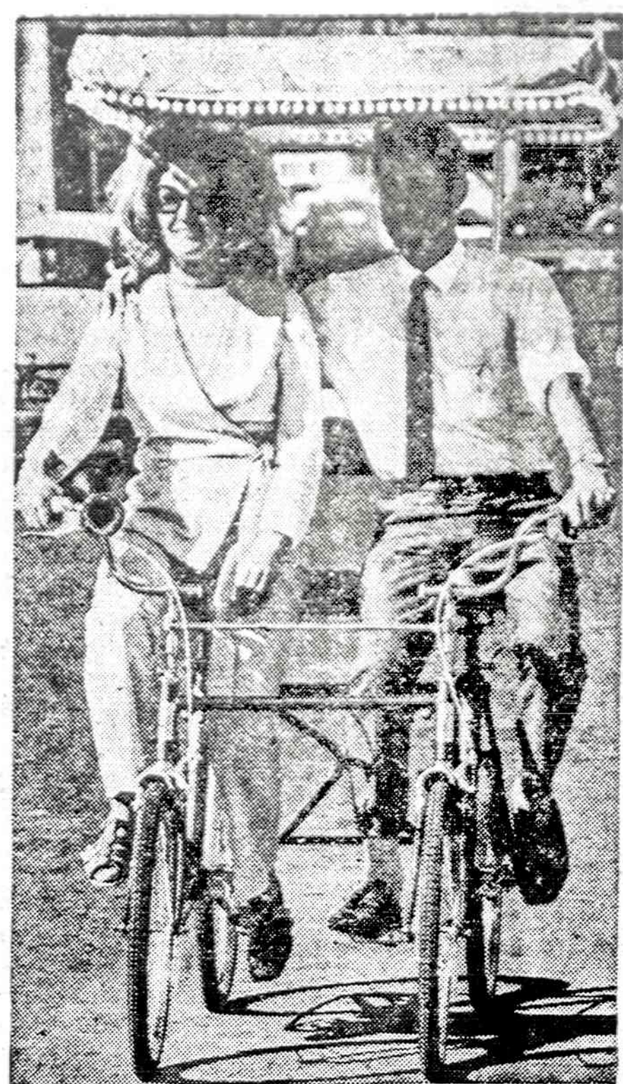
Dviem žmonėm pagaminti dviračiai yra ne naujiena, tačiau lig šiol vienas žmogus sėdėdavo kito užpakalyje. Naujosios Zelandijos inžinierius atėjo mintis pagaminti dviračius, kurių žmonės važiuoja šalia vieno kito. Nuo saulės keleivius pridengia baldakimas.
