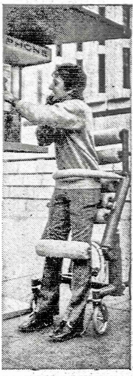
Philadelphijos išradėjas Peter Bressler sugalvojo naują kėdę-vežimėlį invalidams. Kėdė leidžia invalidams atsistoti ir juos prilaiko stovintį, kaip matosi iš dešinėje esančios fotografijos.
