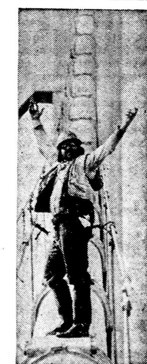
Daitytojas Brookner Brady stovi nesilaikydamas ant San Francisco tilto kabelio, kurį jis rengiasi dažyti. Tai pavojingas ir sunkus darbas, ypač vėjotą dieną.
