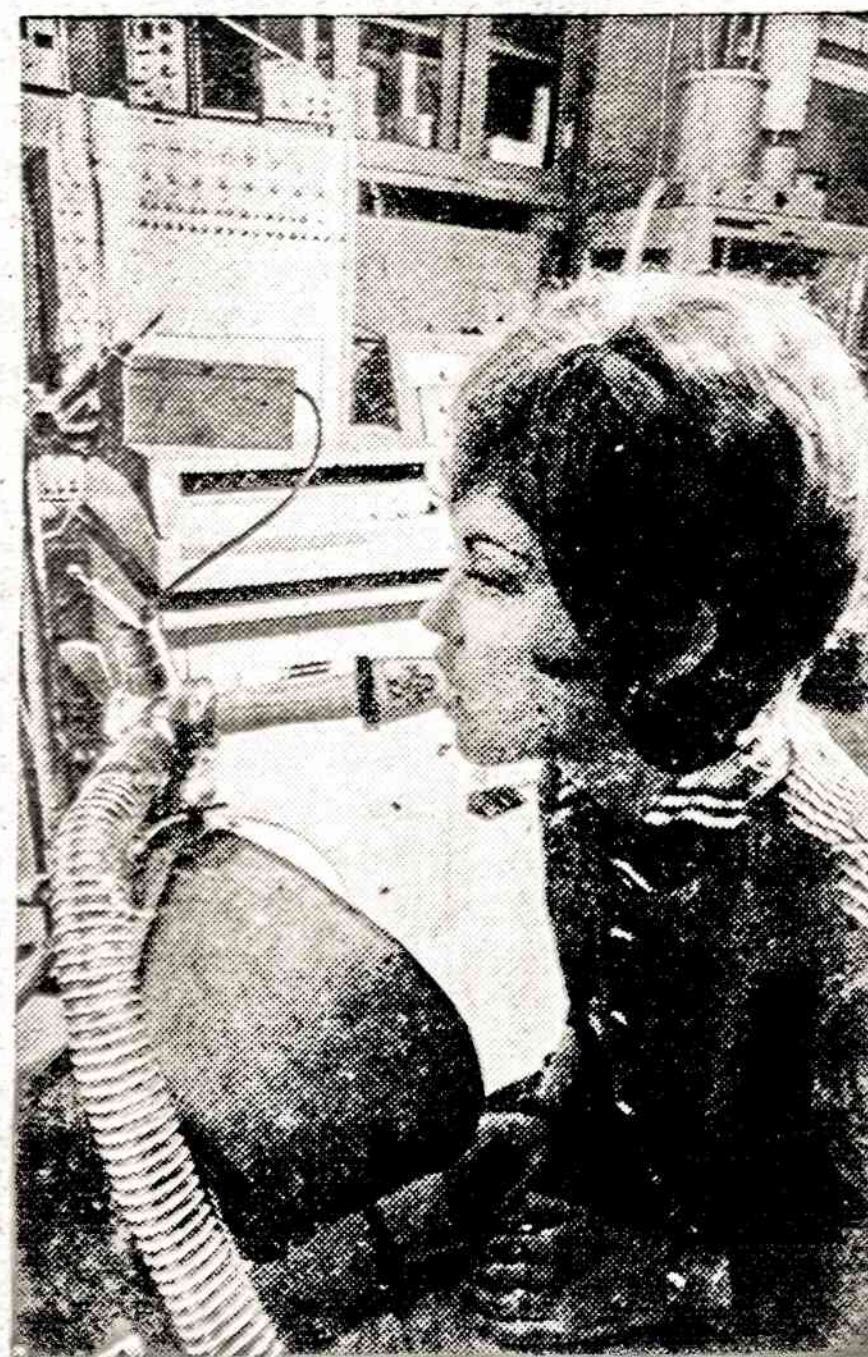
Iš erdvės tyrinėjimų programos daug idėjų perėjo į kasdieninį gyvenimą. Dujų malavimo aparatas, naudotas nuo 1960 metų erdvės atmosferai tyrinėti, dabar pritaikomas medicinos reikams. Aparatas tiksliai nustato kokį orą pacientas įkvepia ir kokį iškvepia.
