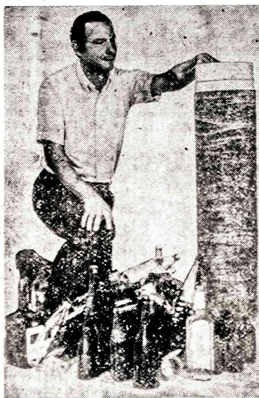
Brookhaven laboratorijoje, Upton, N. Y., rastas būdas, kaip naudoti sunudoti tuščius butelius. Dešinėje matomas kanalizacijos vamzdis pagamintas iš 118 alaus butelių, su visomis etiketėmis ir metaliniais dangteliais. Vamzdyje sutrinti stiklai sumaišyti su skysta plastmasė.
