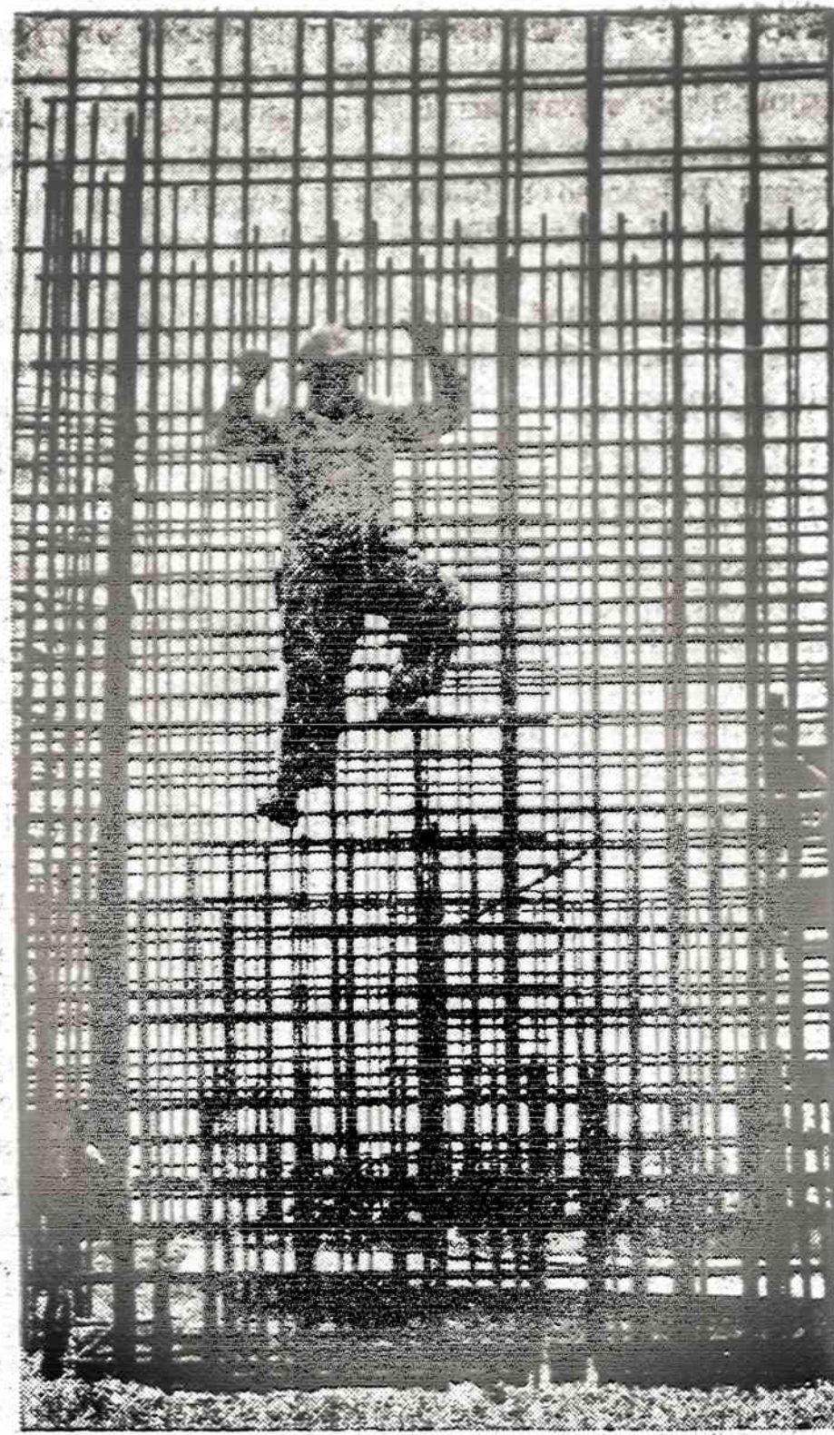
Lyg voras ant savo tinklo, stabybos darbininkas tikrina plieninius virbalus, kurie sustiprins Hibbing Taconite Co. geležies liejyklą Hibbing, Minn. Ši įmonė pagamins per metus 5,4 mil. tonų geležies.
