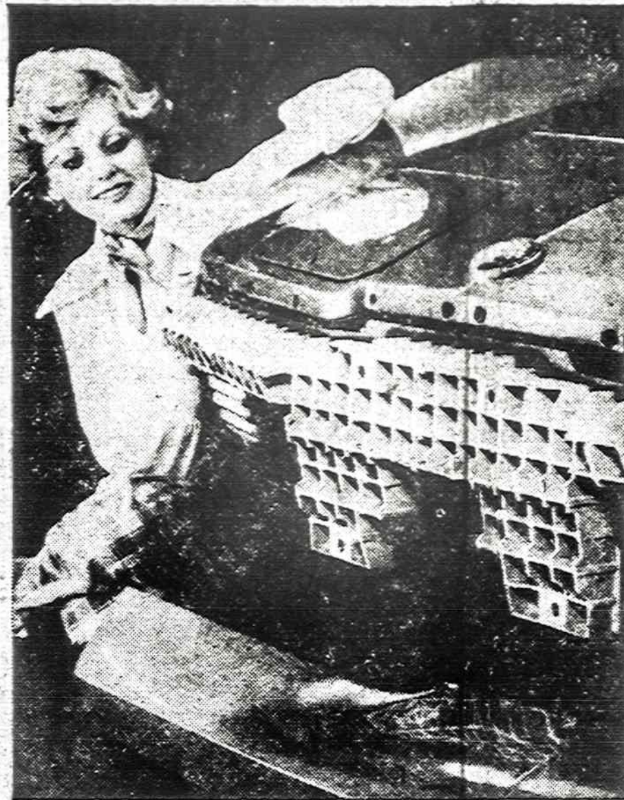
General Motors sugalvojo naują buferių sistemą, kurioje yra ir plastmasinė, minkšta, ir bičių korį panaši uždanga. Po atsitrenkimo ji vėl sugrįžta į buvusią poziciją.
