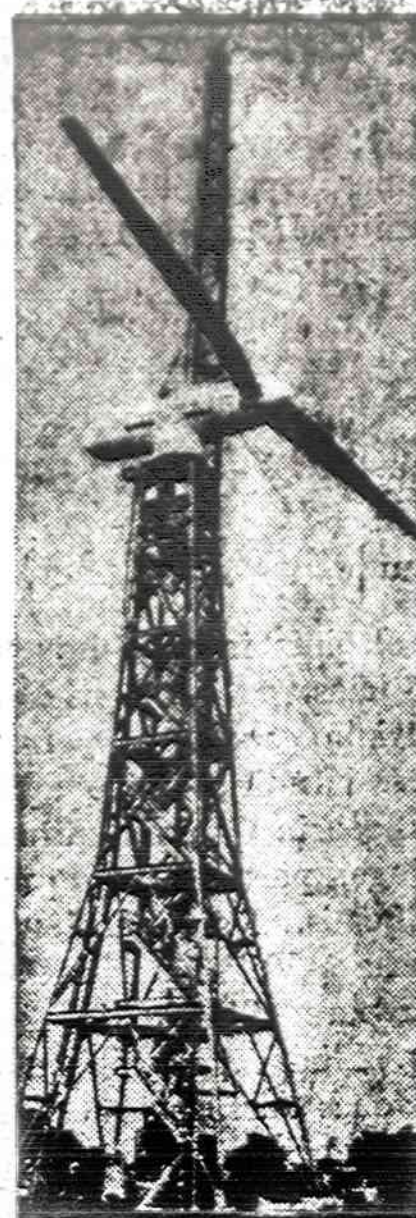
Plum Brook miestelyje JAV Energetikos departamentas įrengė 100 pėdų aukščio bokštą. Viršuje yra įrengtas motorėlis su dviem malūnų sparnais. Sparnai pradeda sukėti 8 mylių vėjas. Kada vėjas pradeda pūsti 15 mylių greičiu per valandą, tai tas iškeltas motorėlis pagamina pakankamai elektros energijos, reikalingos 30 namų aptarnauti. Naudingam darbui įkintytas vėjas gali padėti išspręsti energijos ir aliejaus stoką šiame krašte.
