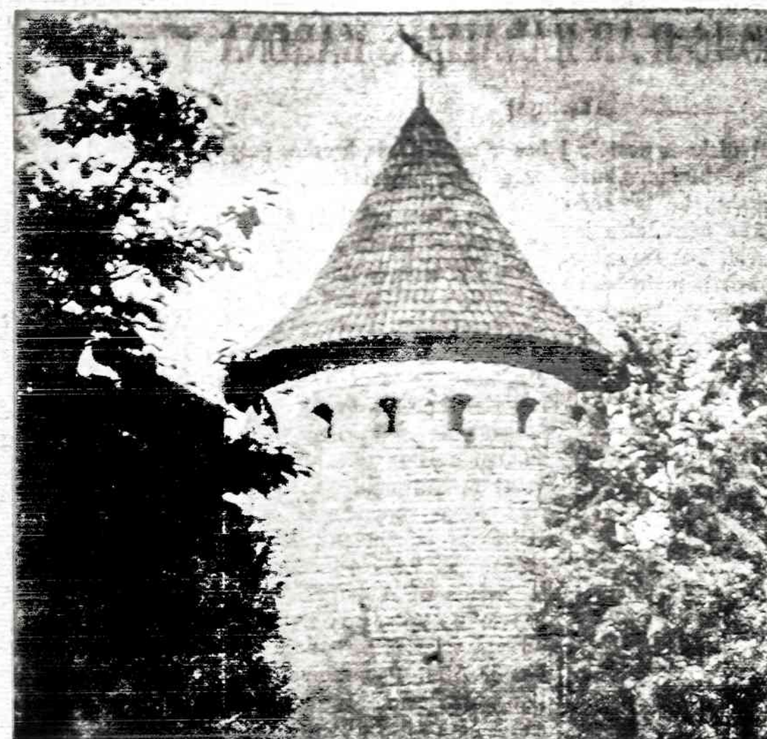
Apsaugos bokštas Kauno miesto sode, rusų pastatytas
