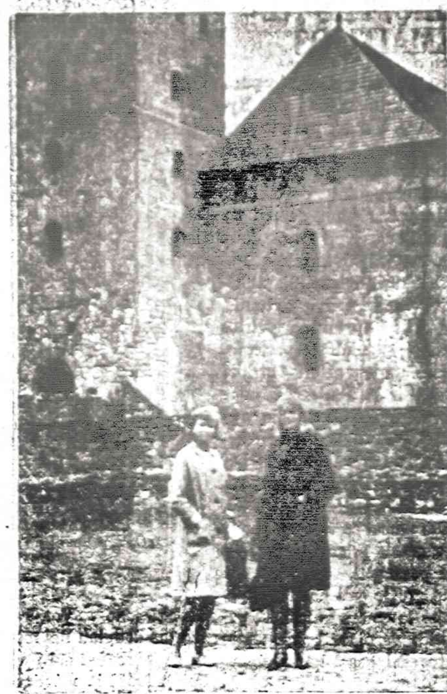
Restauruoja Trakų pilis
