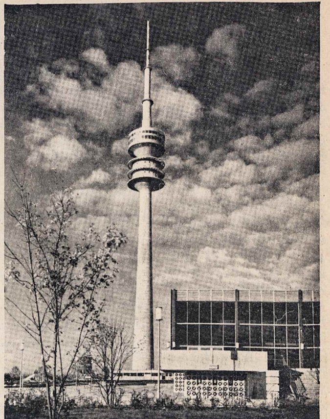
Parengiamieji olimpiados darbai Miuncheno mieste jau pradėti. Paveiksle naujai pastatytos 290 metrų aukščio olimpinis bokštas, iš kurio atsiveria puikus vaizdas į patį miestą ir jo apylinkes.
