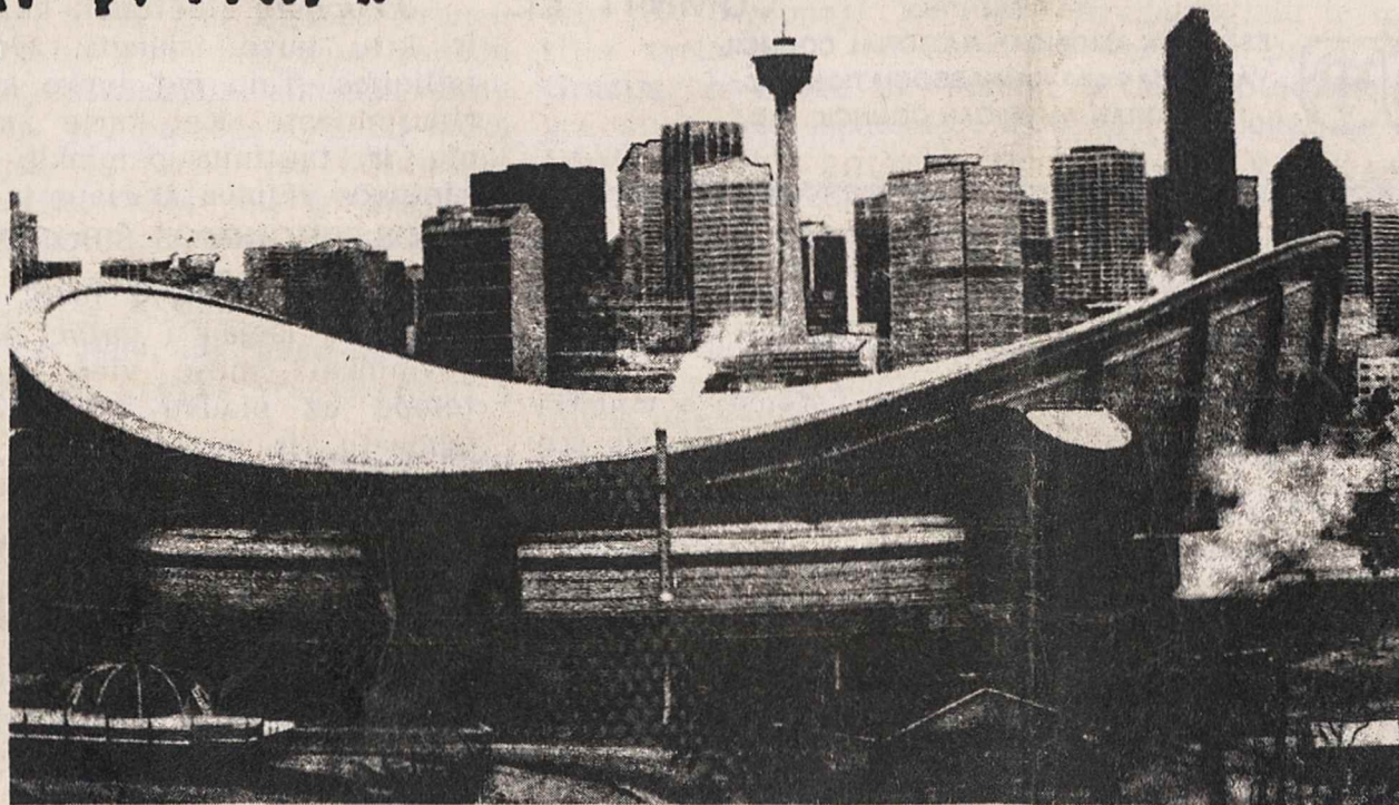
"Saddledome" – vienas pagrindinių olimpinių pastatų Kalgarije.
