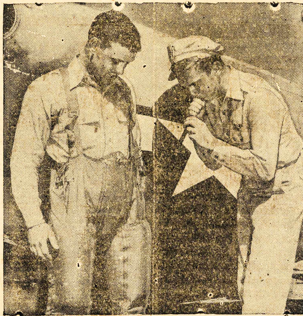
Paveikslas parodo oro pripucziamos kelnės, del apsango-jimiu lakunu nuo galvos svaigimo laike skraidymu ir staigiu vartymusi. Oro pripustos kelnės palaiko spaudima kojose ir kraujas nenuslugsta in žemutines kuno dalis.
