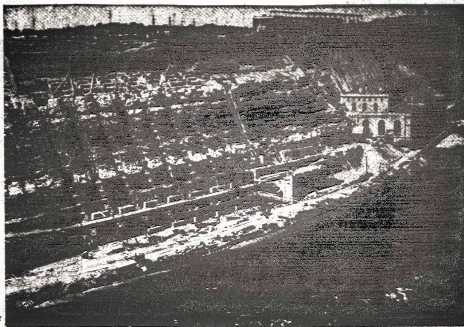
Ontario Hydro statybos darbai
