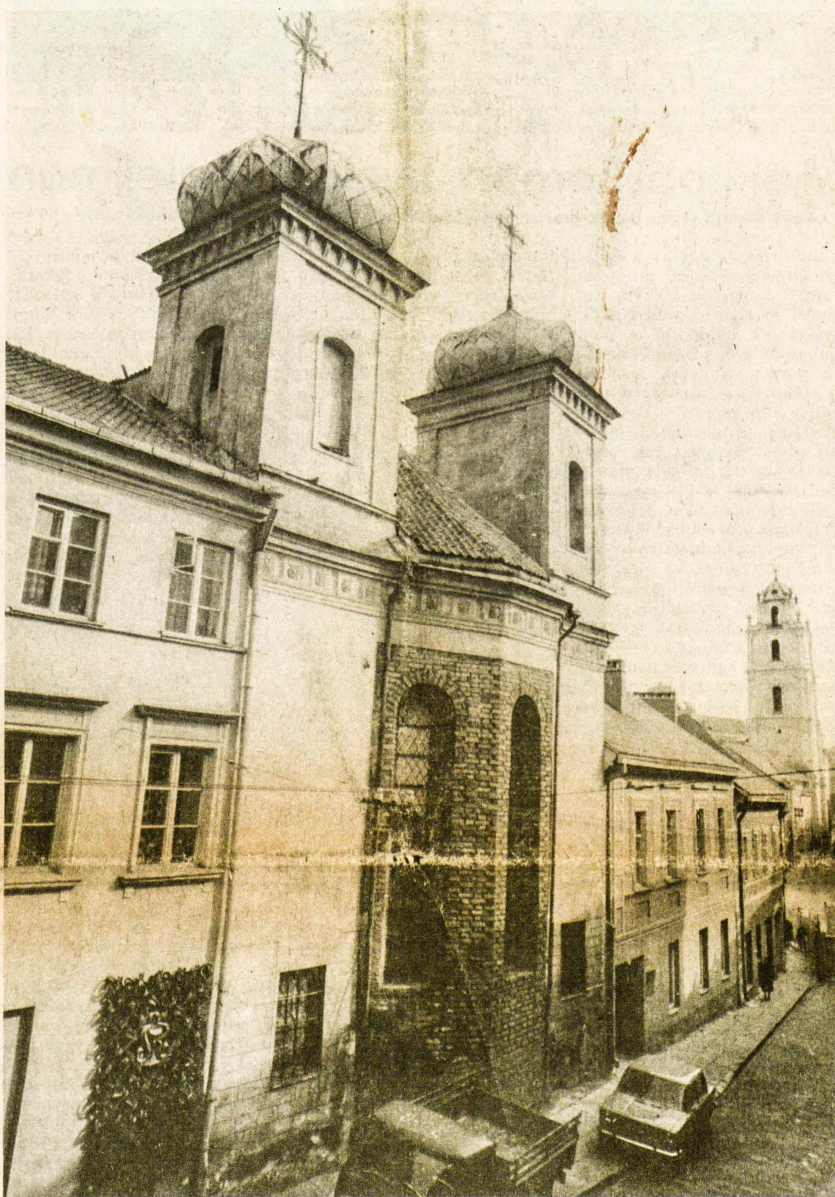
Vilniaus Šv. Trejybės šventovė, kurioje sovietai įrengė gimnastikos salę, stalo tenisą ir pan. Po II D. karo priekine pastato siena sugriuvo. Ji buvo atstatyta, bet priekinės durys užmūrytos ir įėjimas padarytas iš šoninės gatvės. Nė viename Vilniaus albume šios šventovės nėra. Ją galima pamatyti senose litografijose
