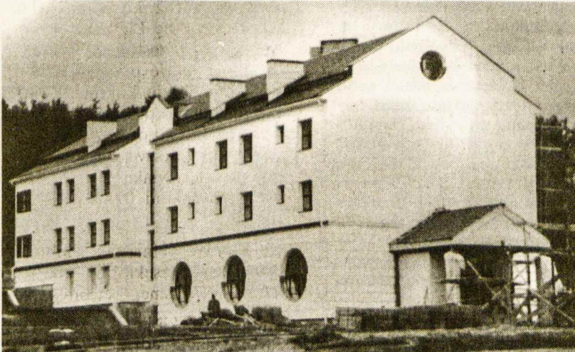
Šv. Jono Bosko vardo naujos parapijos pastatas Vilniaus priemiestyje Lazdynuose. Jame įrengta koplyčia, saleziečių vienuolynas ir kitos parapijai reikalingos patalpos
