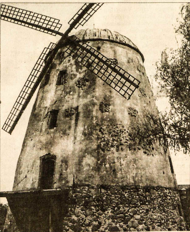
Šėduvos malūne dabar įrengtas restoranas
