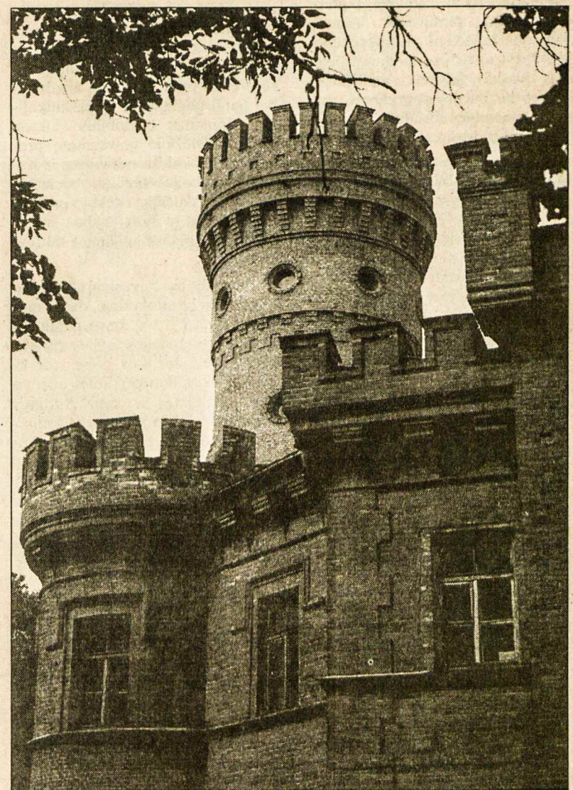
Kertinis Raudondvario pilies bokštas
