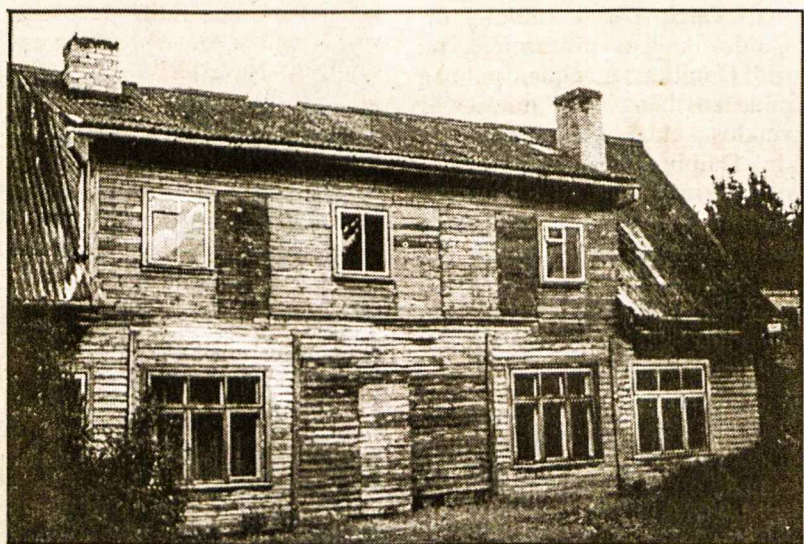
Kunigo klebono A. Kibirkščio iniciatyva vyksta remonto darbai parapijos namuose, Druskininkų (Ratnyčios) Šv. ap. Baltramiejaus parapijoje. Tikimasi išsivijos paramos
