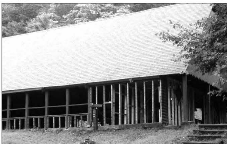
Skautų stovyklavietėje „Romuva“ jau pradėti pagrindinių pastatų atnaujinimo darbai – dedamos naujos grindys ir sienos
